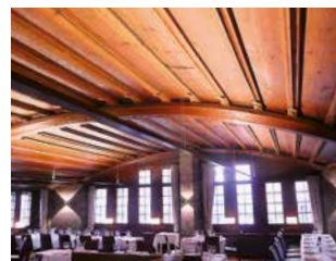
Gewölbte Holzdecke im Restaurant zum Rüden, erbaut 1348
