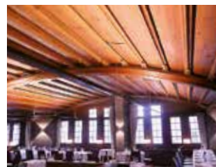
Gewölbte Holzdecke im Restaurant zum Rüden, erbaut 1348
